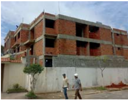
Fachada da colônia vista da rua Santa Rosa
